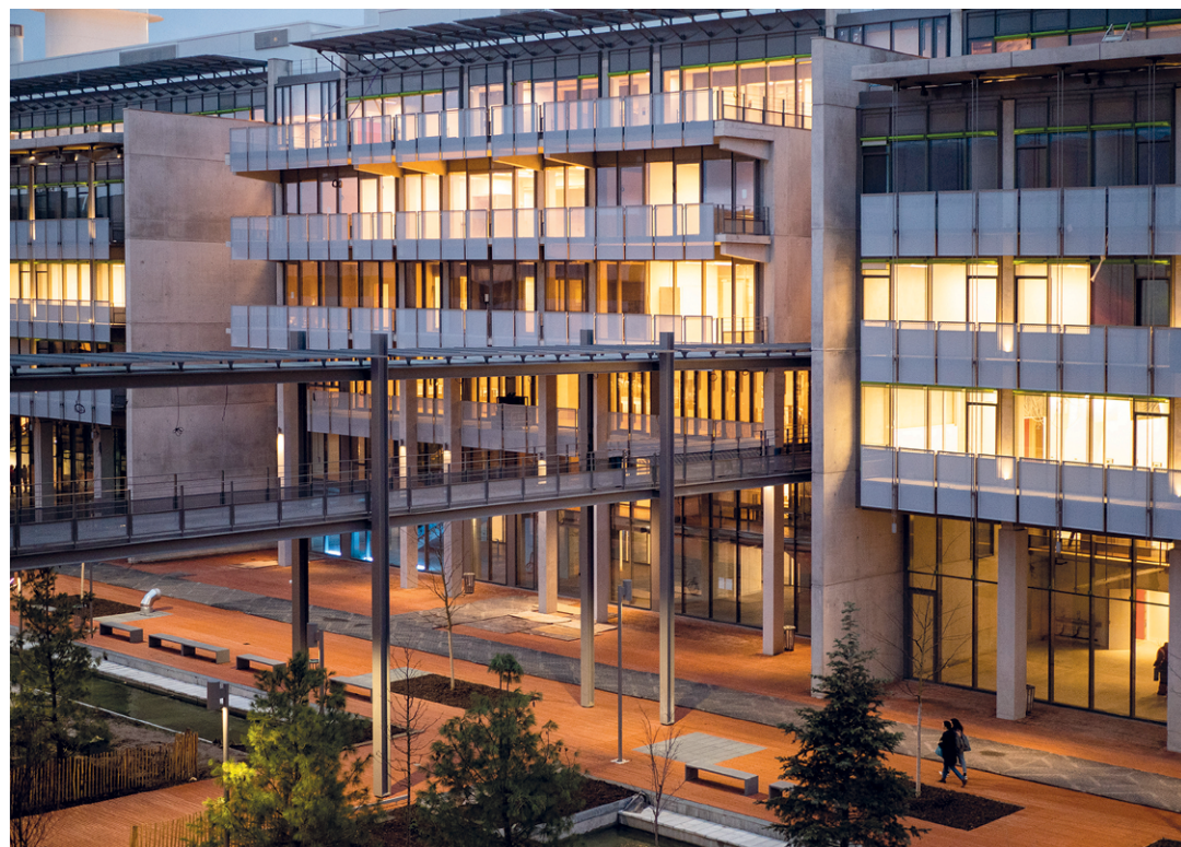
Vue des bâtiments Nord et Est depuis le jardin
